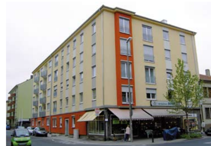
Fassade nach der Sanierung
