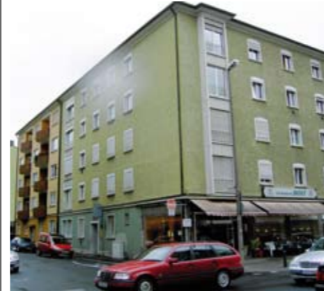
Fassade vor der Sanierung
