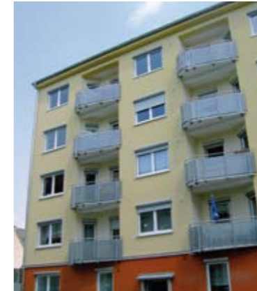
Nach der Sanierung mit Balkonen
