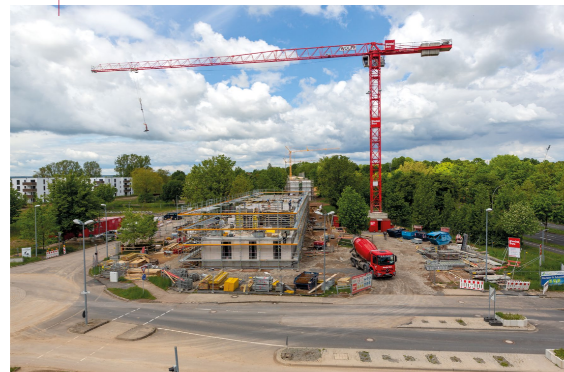
Überblick über die Baustelle
