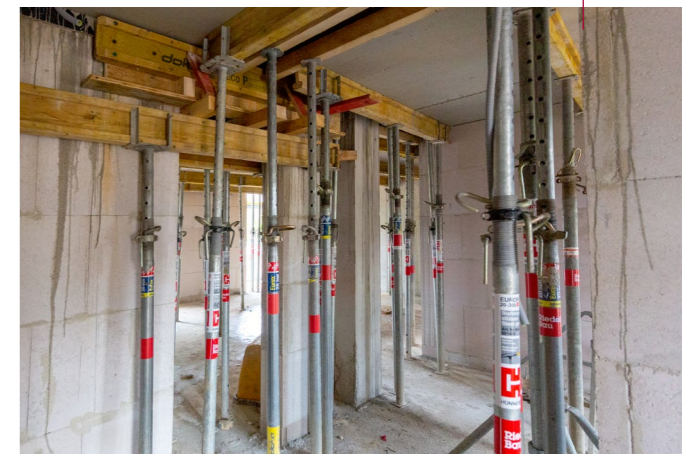
Schalungsarbeiten im Gebäude
