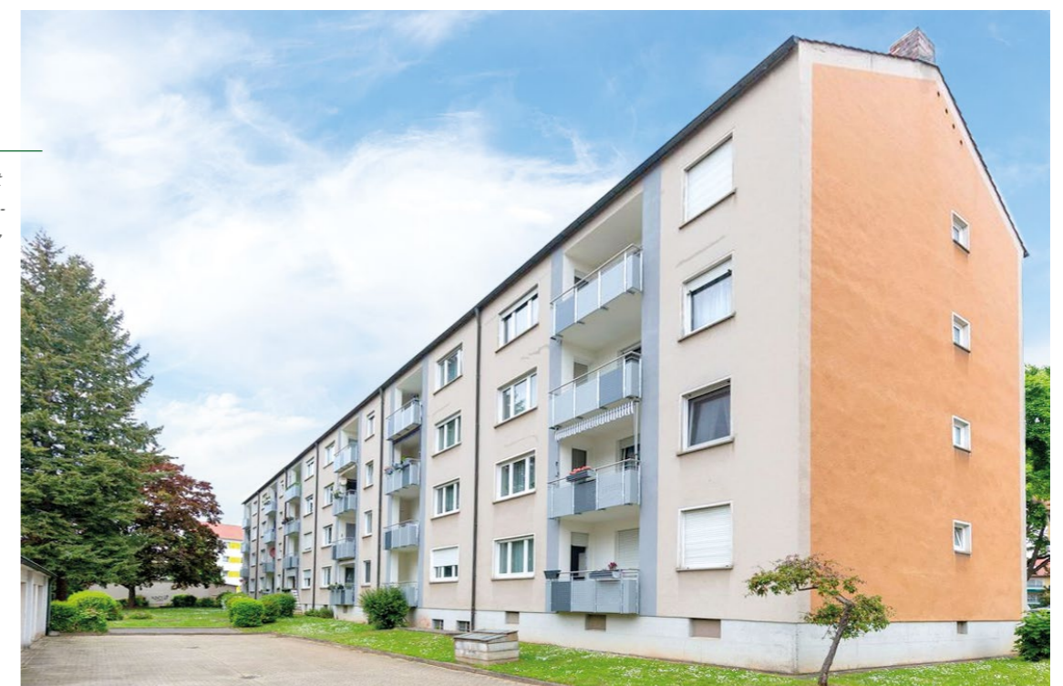
Innenhof-Ansicht Gerhart-Hauptmann- Straße 23-27
