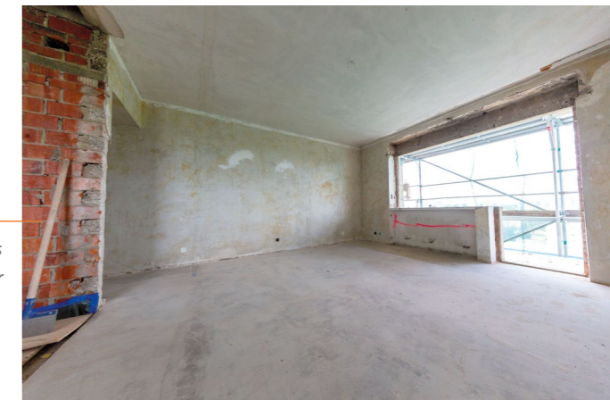
komplett entkerntes Wohnzimmer
