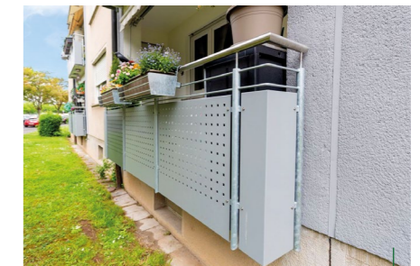
neues Balkongeländer mit Lochblechverkleidung und Edelstahl-Handlauf
