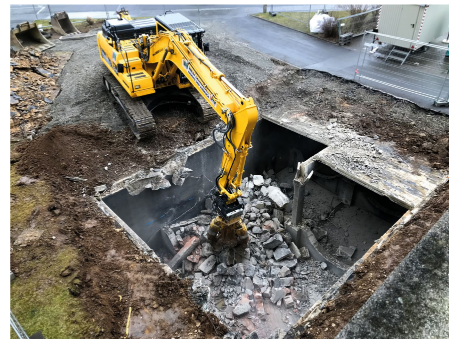
Rückbau des ehemaligen Tanklagers
