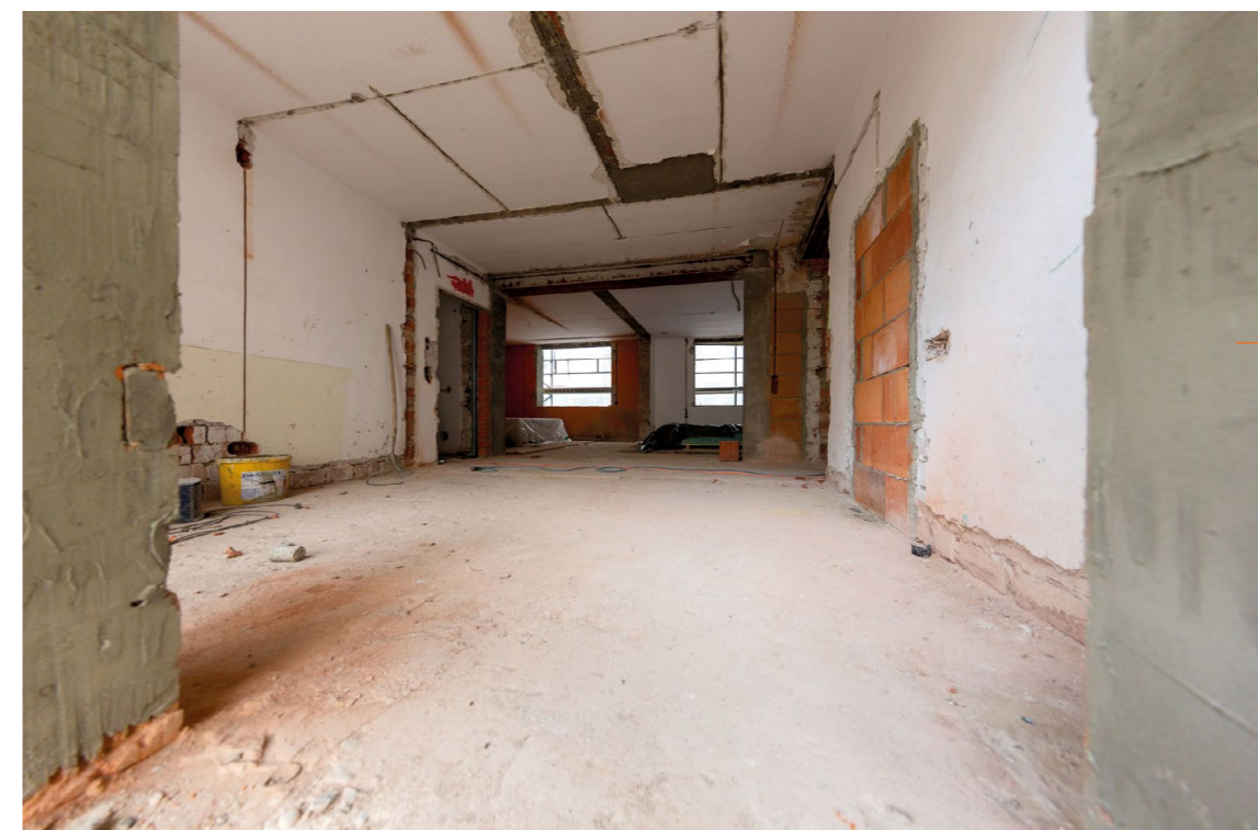
Blick in den neuen Gemeinschaftsbereich im Erdgeschoss
