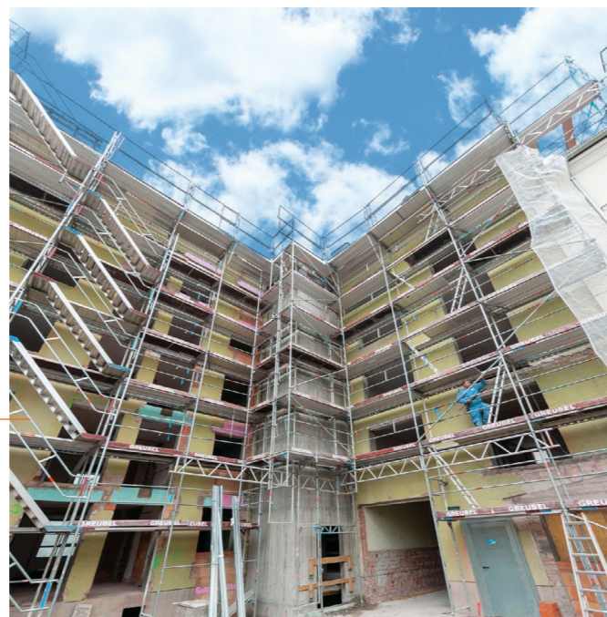
Rohbau des neuen Aufzugsschachtes
