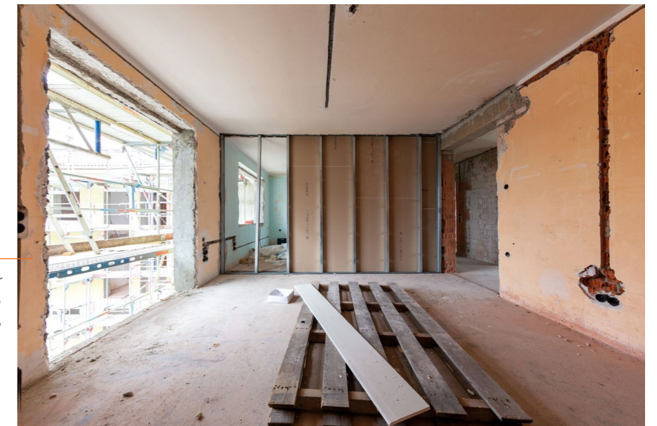
Montage einer neuen Innenwand in Trockenbauweise
