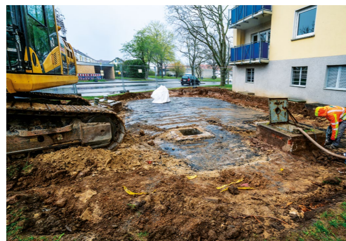
Freilegung des nicht mehr benötigten Heizölbunkers
