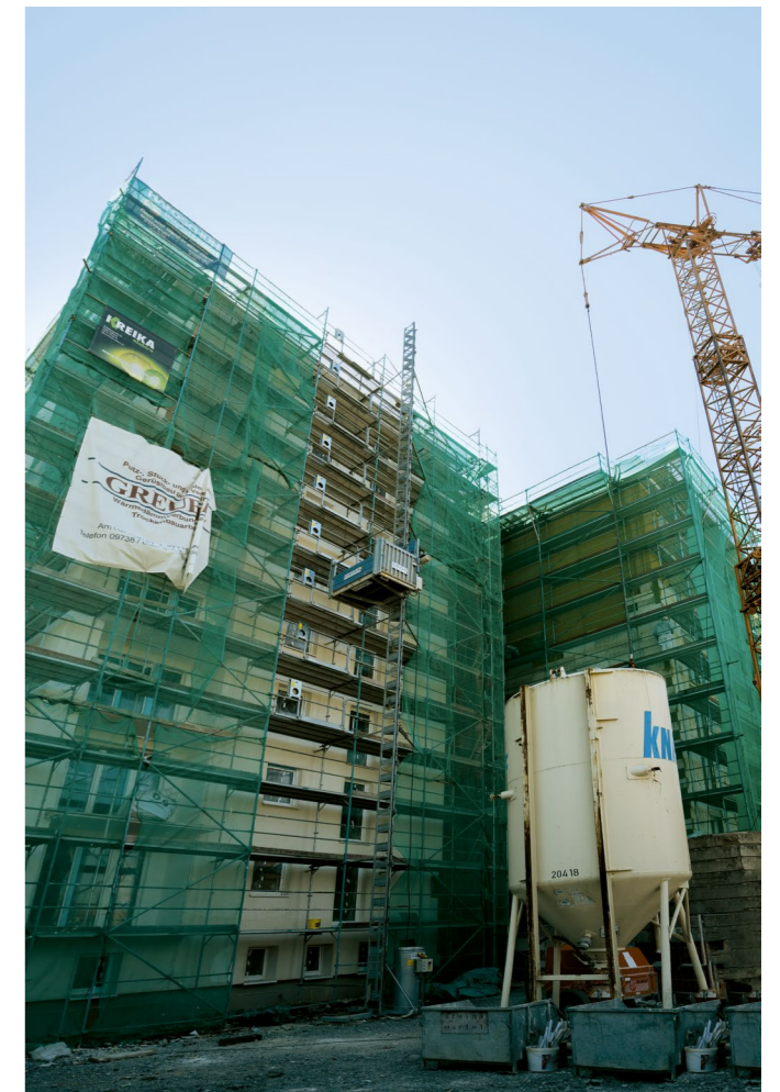
Arbeiten an der Gebäudehülle
