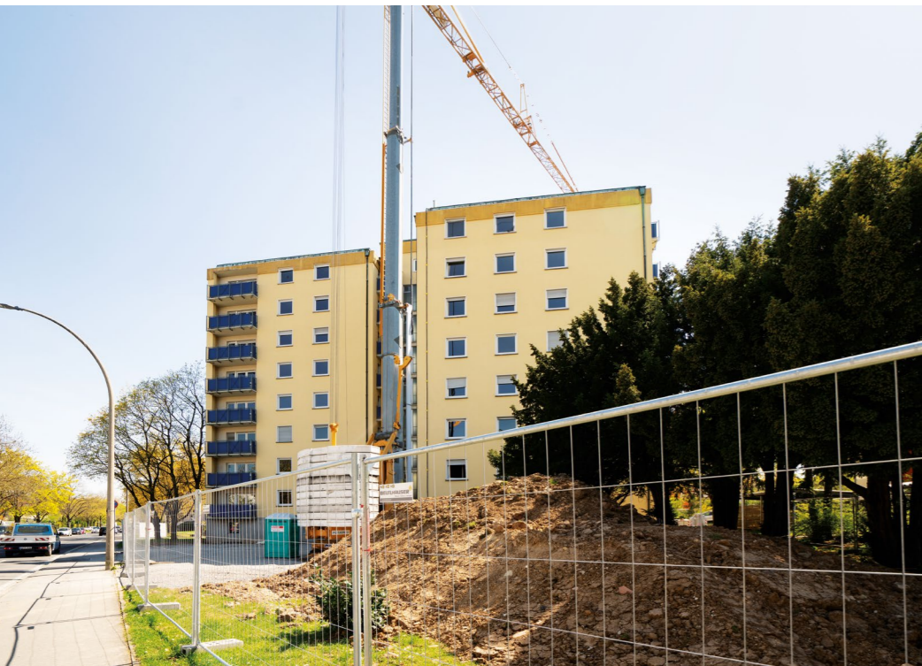
Der Baukran lässt die Baustelle schon von weitem erkennen
