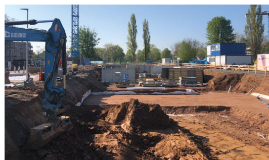
► Abschnittsweise entstehen die einzelnen Gebäudekörper
