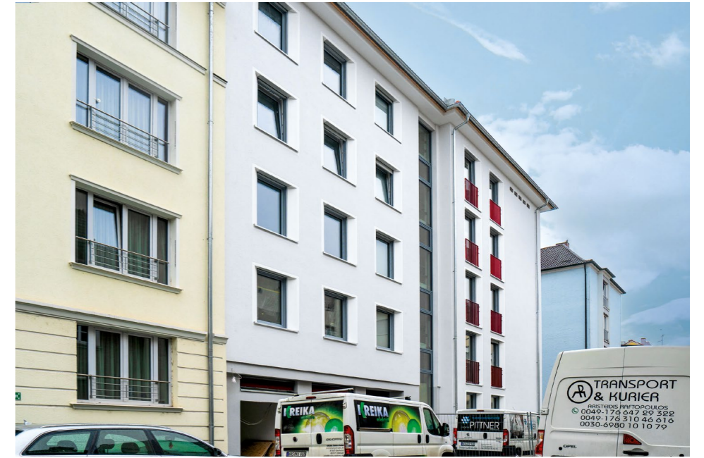
► Blick aus der Theresienstraße auf die neue, gedämmte Fassade
