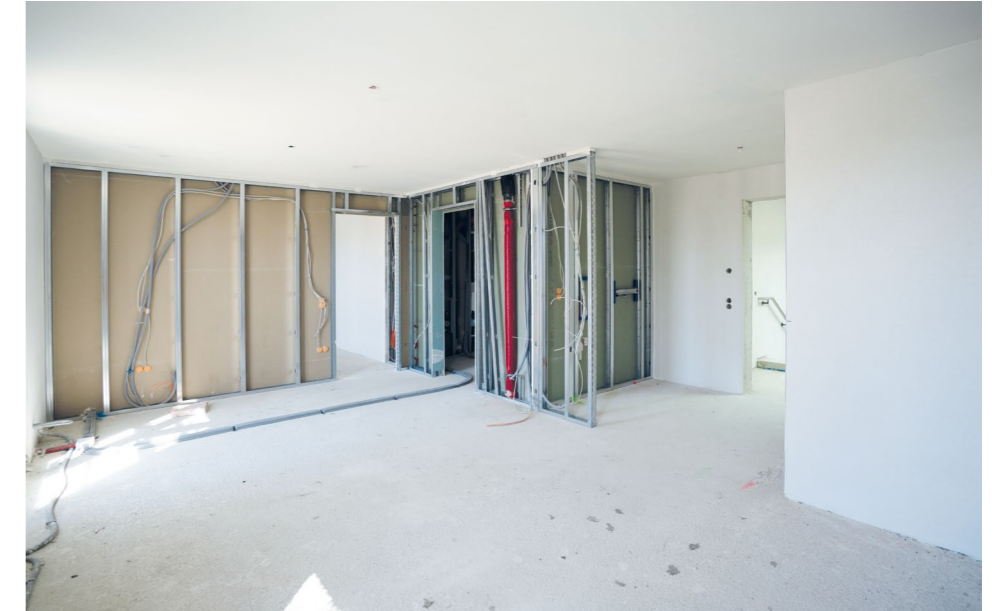
› Mittels Trockenbauwänden entstehen verschiedenen Räume in der Wohnung
