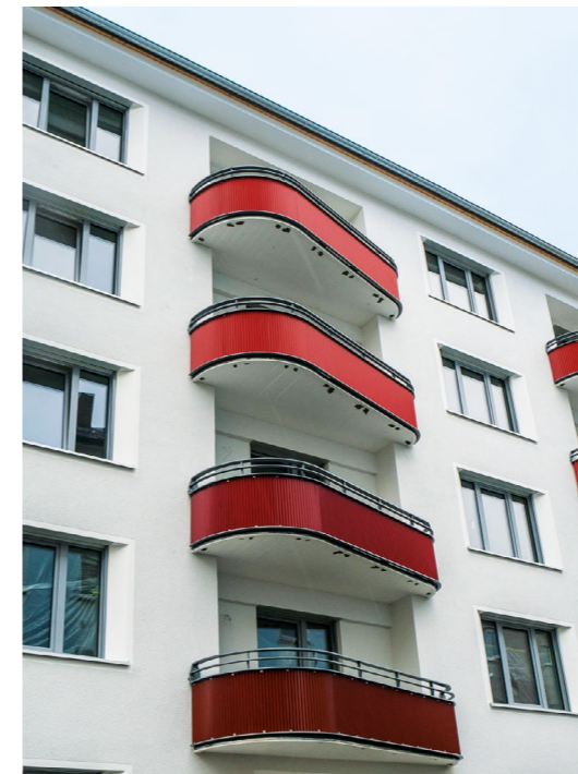
► Die neuen Balkone laden zum Entspannen ein
