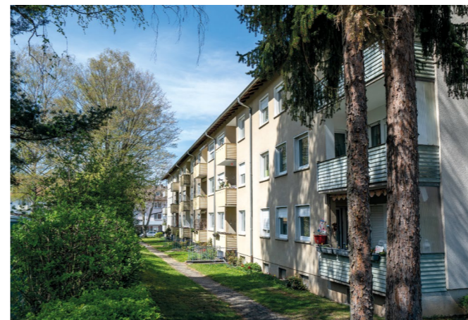
› Blick auf die Gebäudesüdseite
