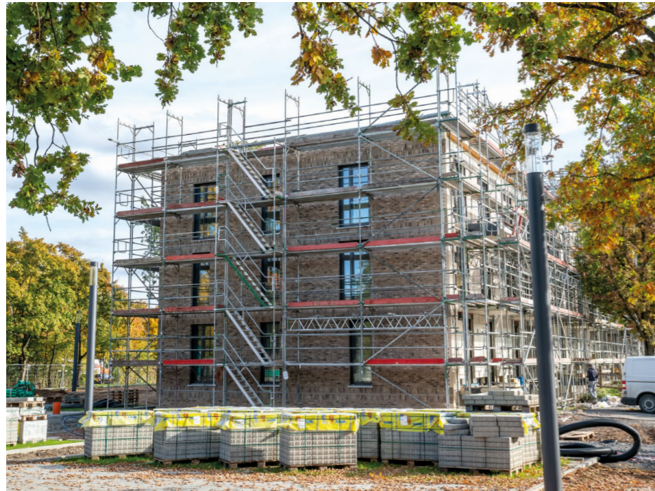
► Herstellung der Klinkerriemchenfassade
