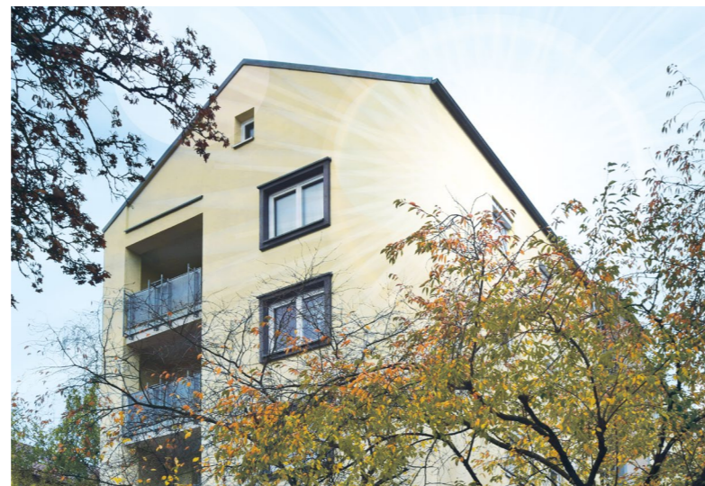
► Giebelfassade nach der Reinigung
