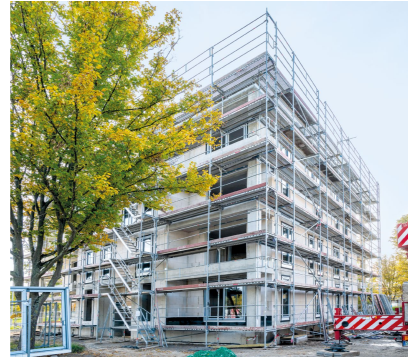
► Einbau der Fensterelemente in der Edmund-Hornung-Straße 1
