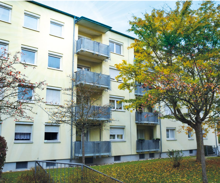
► Balkonfassade nach der Reinigung
