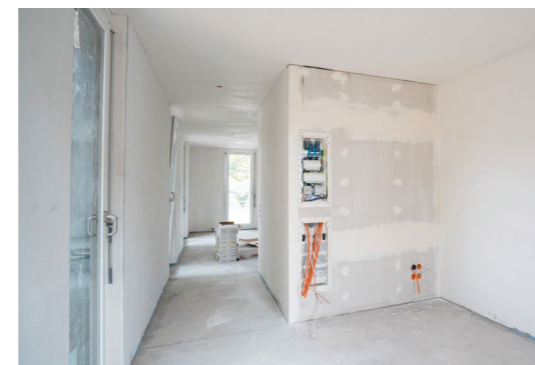
► Wände und Decken sind vorbereitet für die anstehenden Malerarbeiten
