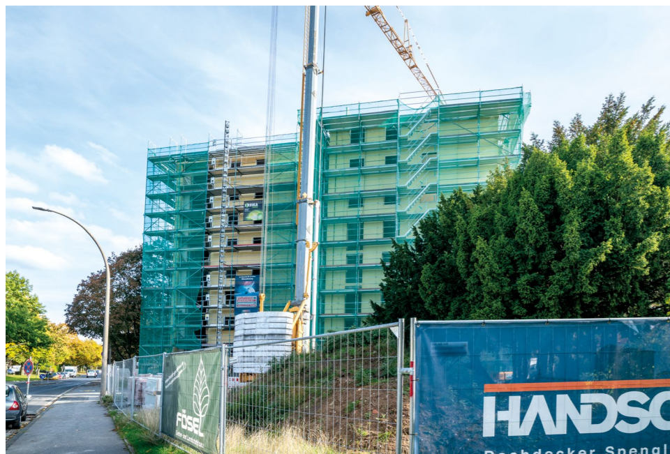
› Bereits von weitem ist die Baustelle in der Oskar-von-Miller-Straße zu sehen
