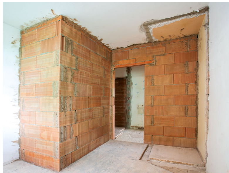
› Durch neue Innenwände entstehen neue Wohnungszuschnitte
