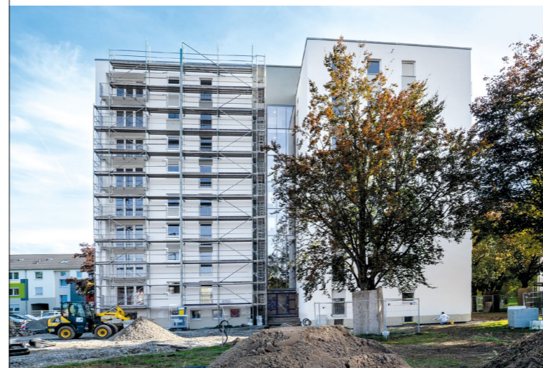
› Der Baufortschritt ist auch von außen deutlich zu erkennen
