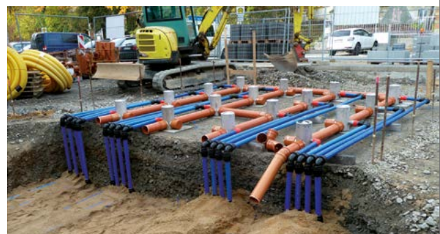
Der Innenhof – Die letzten Arbeiten werden fertiggestellt
