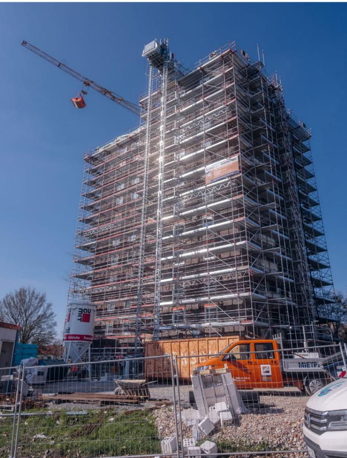
Das gesamte Gebäude ist mit einem Gerüst umhüllt, um insbesondere die Fassadendämmung anbringen zu können
