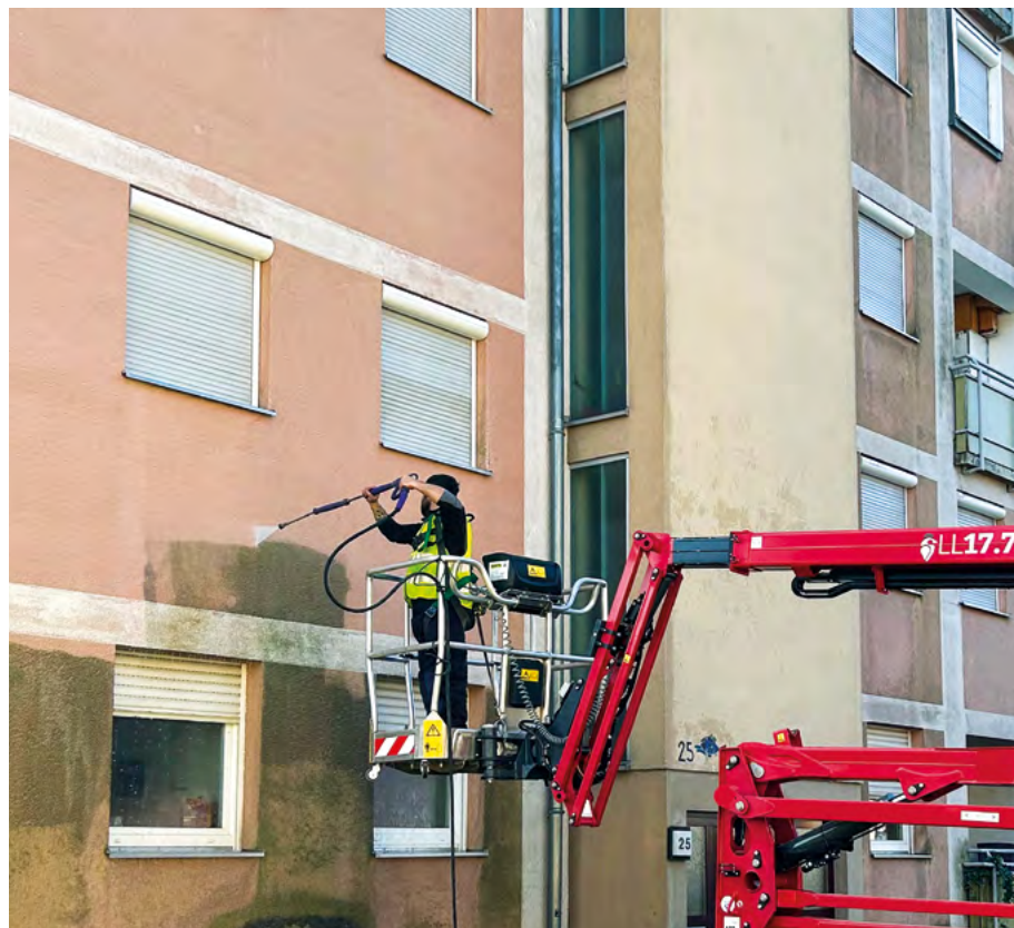
Fassadenreinigung in der Breslaustraße 25–45 für ein sichtbar aufgewertetes Wohnumfeld.
