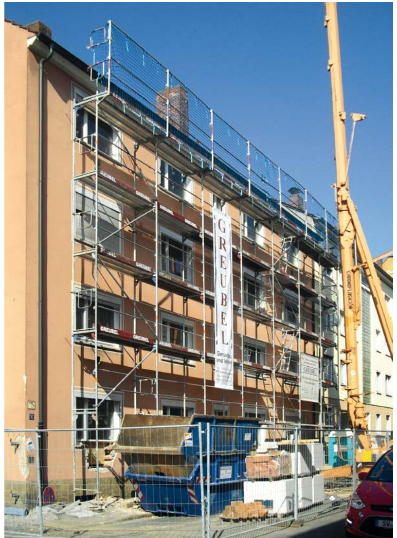
Modernisierungsarbeiten in der Cramerstraße 15
